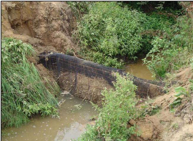
**Figure 54: Exemple d'un barrage filtrant constitué de paille aérée.**
