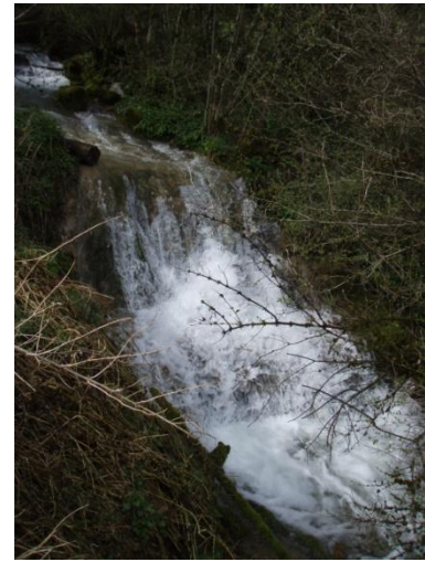
Figure 15: Seuil majeur sur le tronçon 3.
