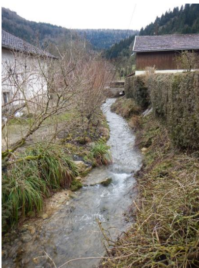
Figure 14: Aperçu du tronçon 2.
