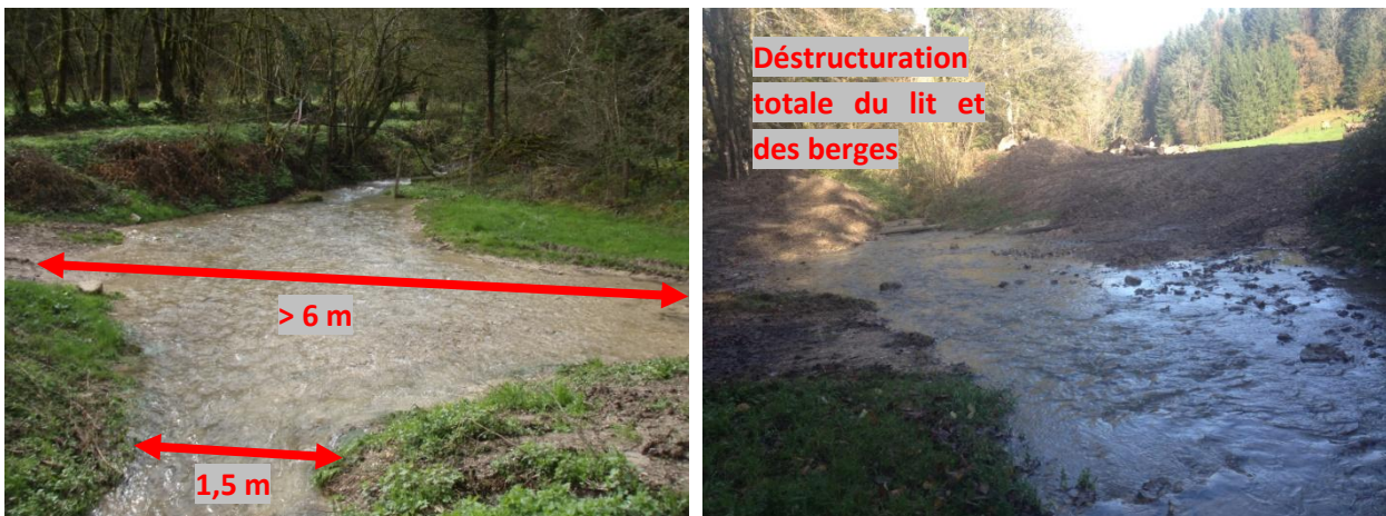
Figure 16: Vue vers l'amont (à gauche) et vers l'aval (à droite) du passage à gué sur le tronçon 4.
