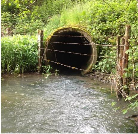
En amont du tronçon 2, le ruisseau de l'Etang s'écoule dans une buse de diamètre 1000 sous la route départementale 13 sur une quinzaine de mètres linéaires. Le franchissement de ce tronçon par la faune piscicole paraît relativement difficile du fait d'un écoulement sur une très faible hauteur d'eau à l'étiage et d'une mise sous pression sans zone de repos en période de crue.
