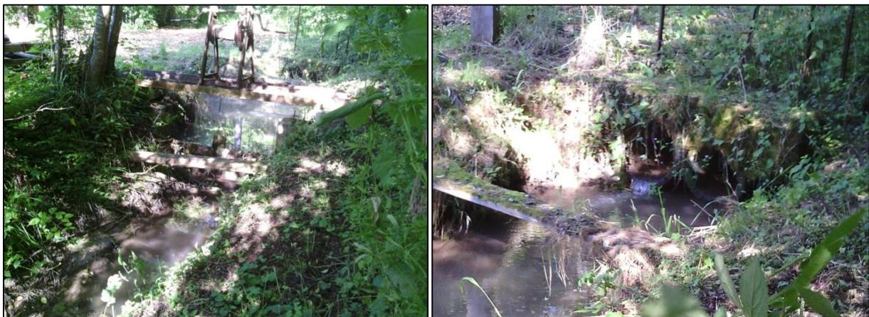
Figure 35: barrage-vanne pour la prise d'eau d'un étang et double buses quelques mètres en amont.
