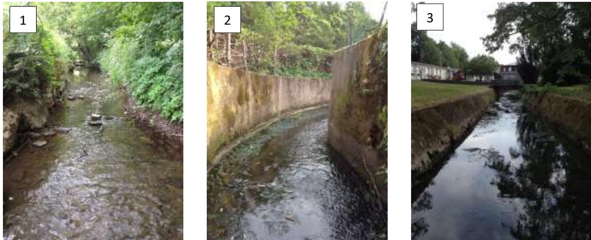
Figure 4: Aperçu du tronçon en amont de la confluence avec le Doubs (1). Aperçu du tronçon 2, des berges maçonnées et du lit bétonné (2 et 3). La faible diversité des écoulements sur les clichés 2 et 3 n'est permise que par la présence massive d'algues vertes filamenteuses.
